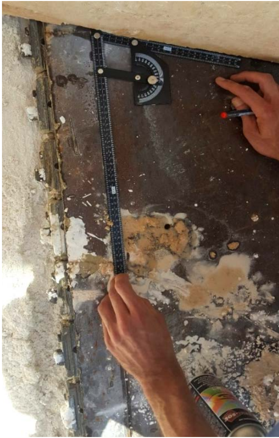
Slika 3.61. Određivanje kuta između mača i pravca rezanja lančane sjekačice
