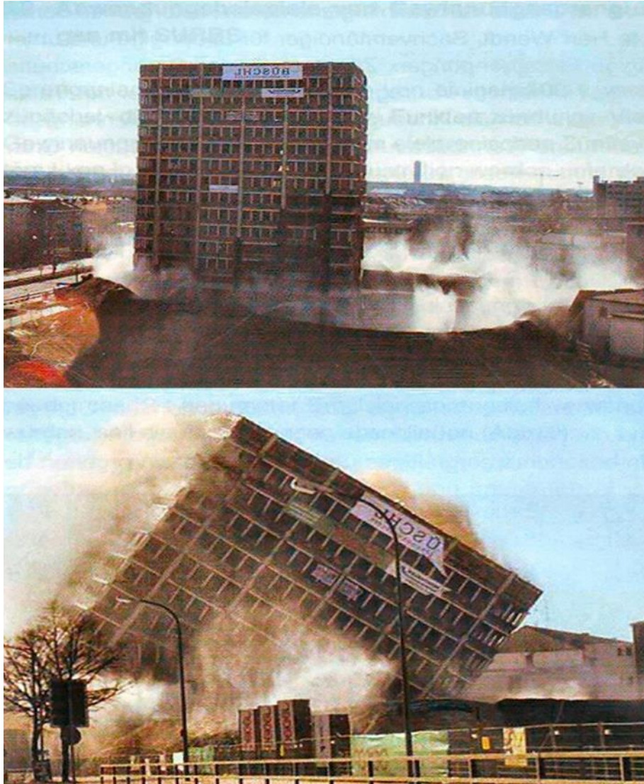
Slika 2-4. Rušenje objekta rotacijom (Ester Z., Dobrilović M., 2016.)
