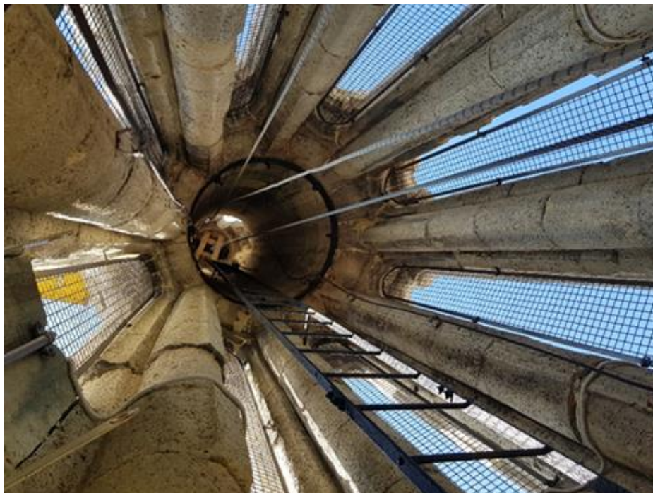
Slika 4-2. Unutrašnjost tornja (Bohanek i Dobrilović, 2020 )
