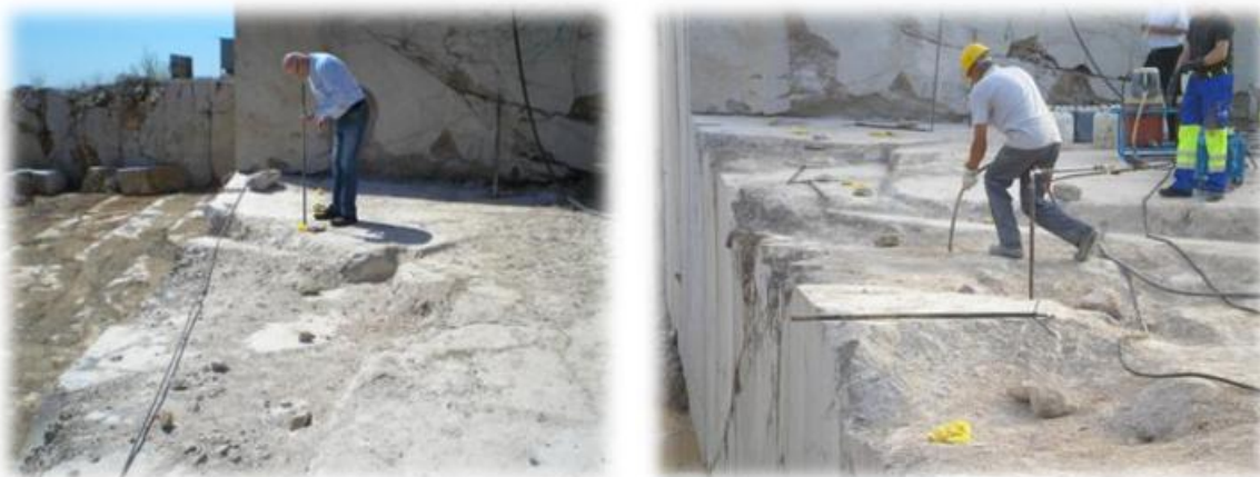
Slika 7.19. Provjera stanja, prohodnosti i dubine utisnih bušotina
