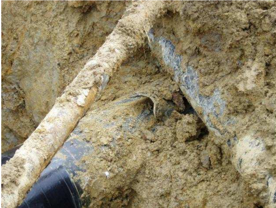
Slika 5-16. Lokacija križanja naftovoda OS Graberje – OS Stružec s plinovodom kompanije Plinacro d.o.o. na udaljenosti od OS Graberje 4020 m (Tehnička dokumentacija INA, 2004)
