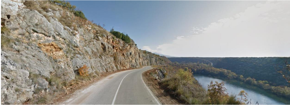
Slika 3.11. Pogled prema jugozapadu na jezero Brljan te na istraživane stijenske kosine u zasjecima na dionici ŽC-6055.
