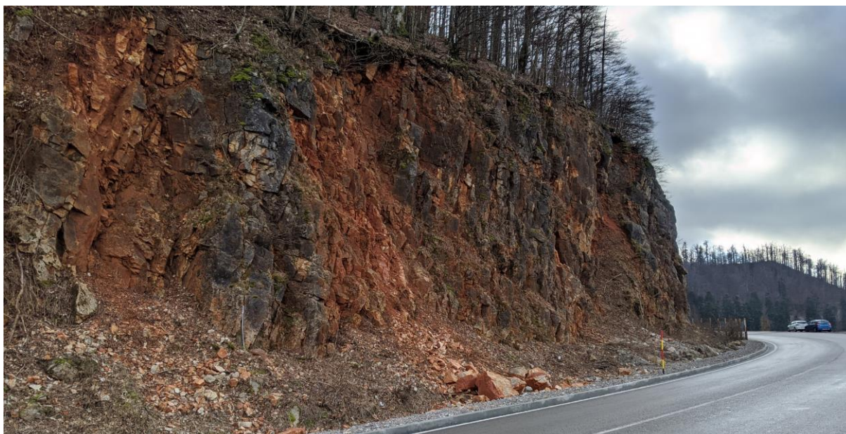
Slika 3.18. Pogled prema JZ na središnji dio stijenskog zasjeka na lokaciji Špičunak uz Državnu cestu DC-3 u blizini Lokvarskog jezera.
