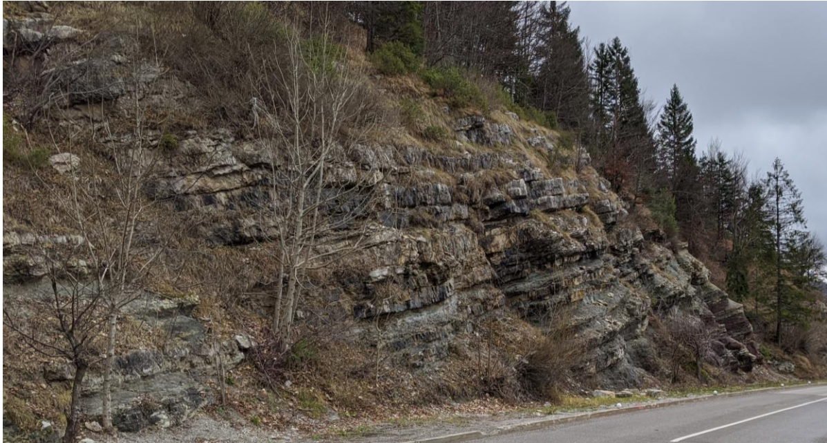
Slika 3.23. Pogled prema SI na zapadni dio istraživanih stijenskih kosina u Lokvama.
