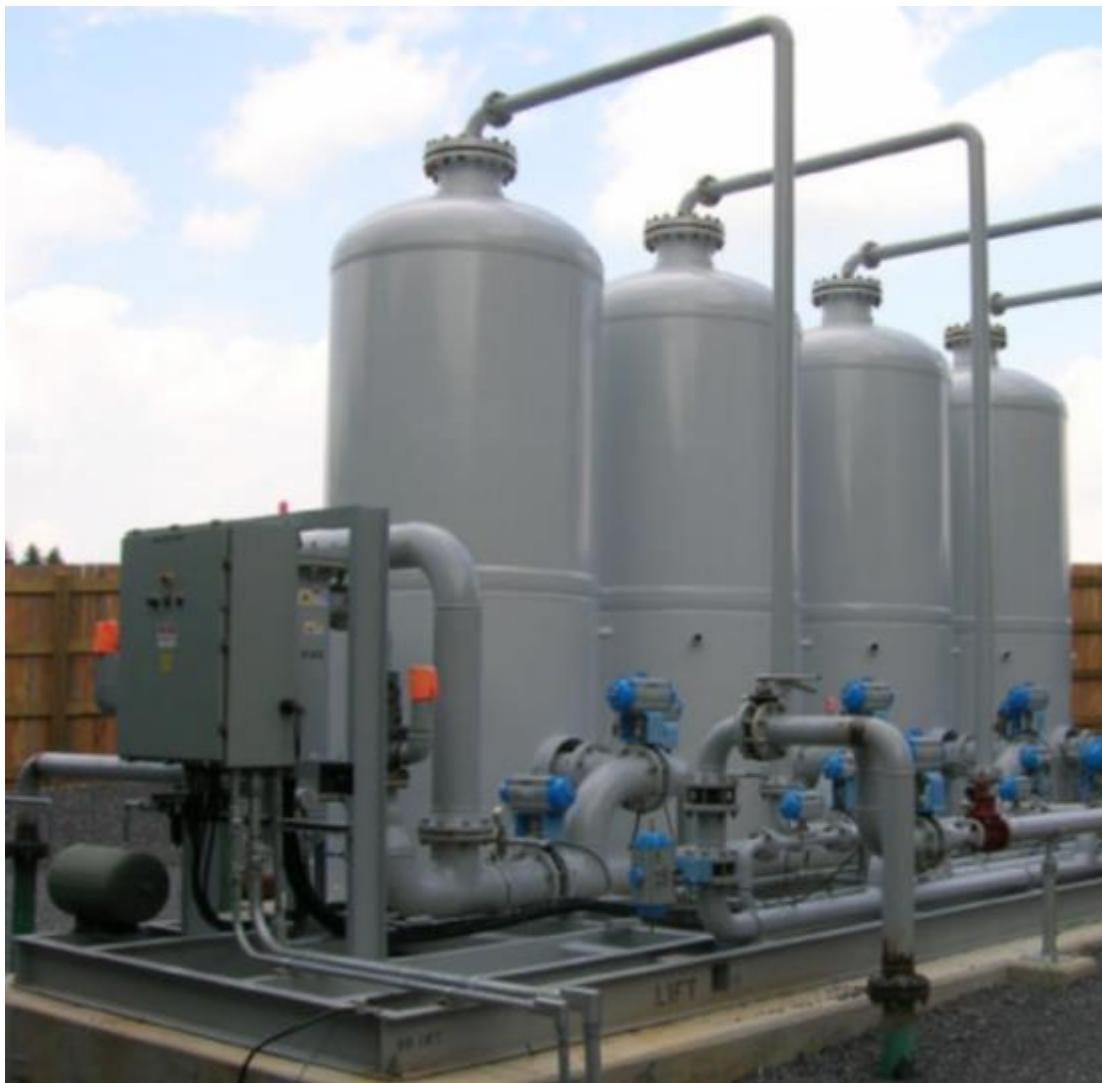
**Slika 2-4.** *Molecular Gate* jedinica za izdvajanje dušika iz struje prirodnog plina za protoke od 2360 m<sup>3</sup>/h do 4720 m<sup>3</sup>/h (2-4 MMscfd) (Mitaritan, 2002)
