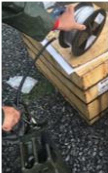
Slika 4-14. Punjenje i montaža kapilarnog voda (INA d.d., 2019)
