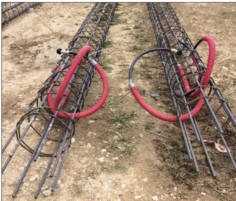
Slika 5.1 HDPE cijevi postavljene na armaturni koš
