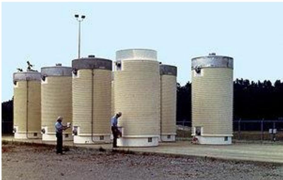
Slika 2-5. Spremniči za suho skladištenje istrošenog nuklearnog goriva
