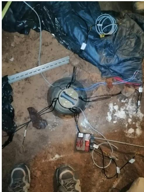
Slika 3-10. Ugradnja senzora, bentonitne ispune i razvrstavanje kablova
