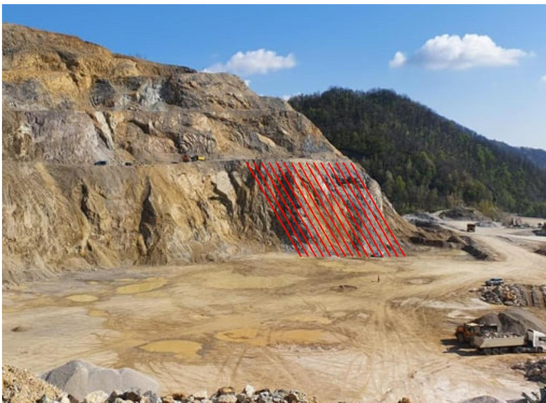
Slika 3.5. Lokacija prvog reda budućih minskih bušotina na eksploatacijskom polju
