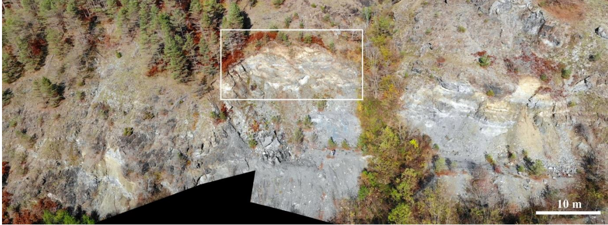
Slika 5.2. Kamenolom u Ljeskovcu. Uokvireni dio detaljno prikazan na slici 5.5.
