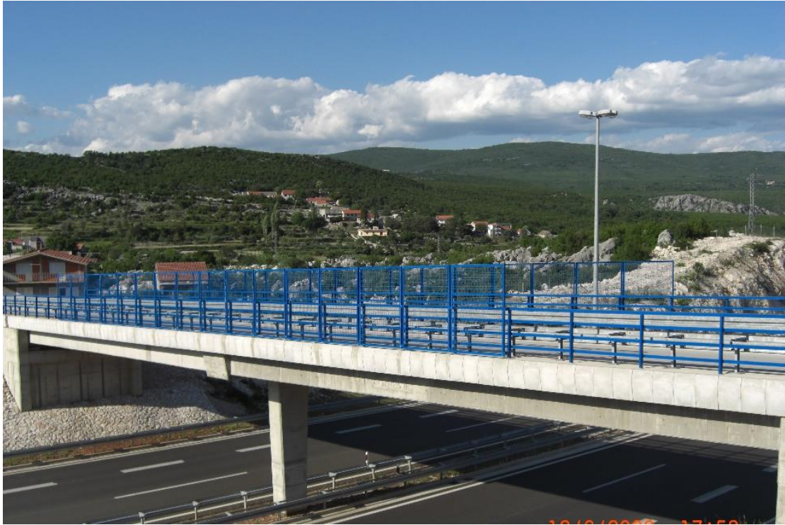
Slika 6-2 Novo stanje nakon izgrađene autoceste (Trnbusi)
