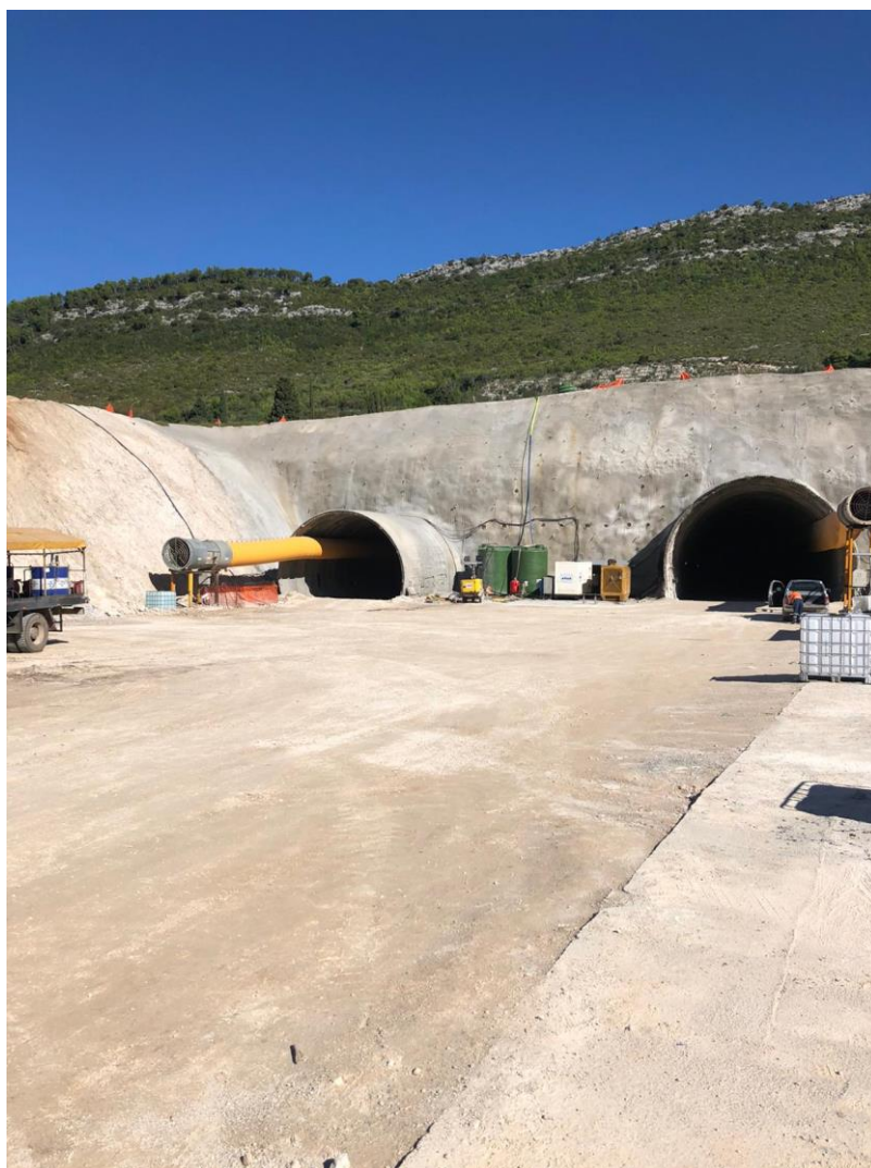
Slika 2.1-1 Ulazni portal s glavnom cijevi (desno) i servisnom cijevi (lijevo) – tunel „Polakovica“
