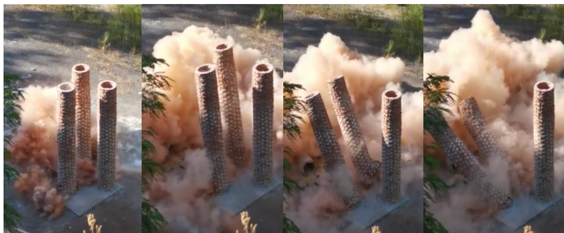
Slika 11-2 Miniranje betonskih dimnjaka
