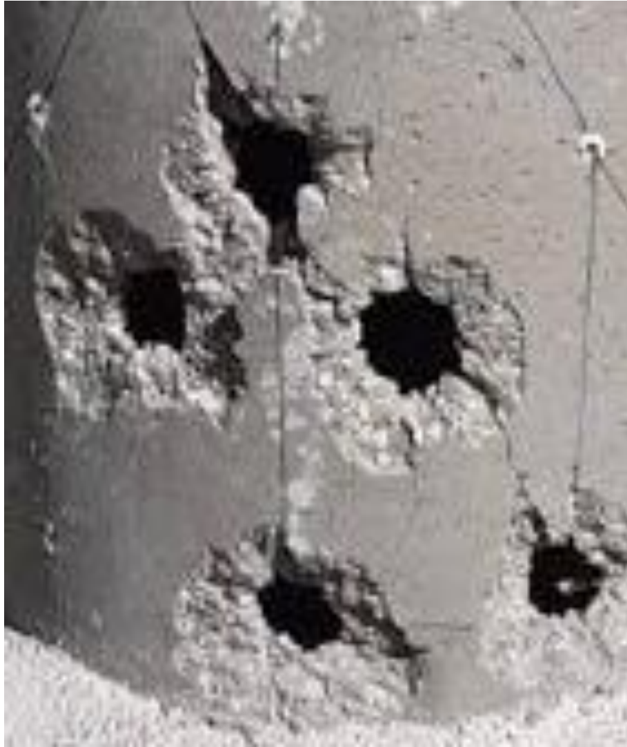
Slika 11-3 Učinak eksploziva na betonskom dimnjaku
