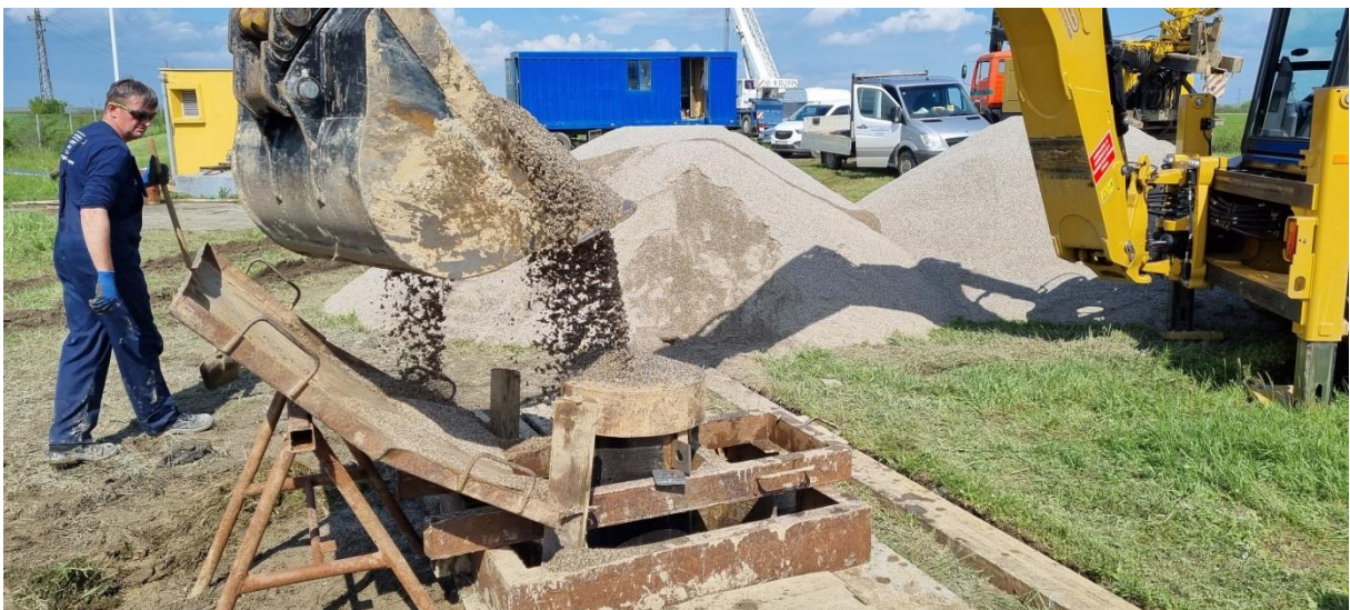
Slika 11: Ubacivanje šljunčanog zasipa
