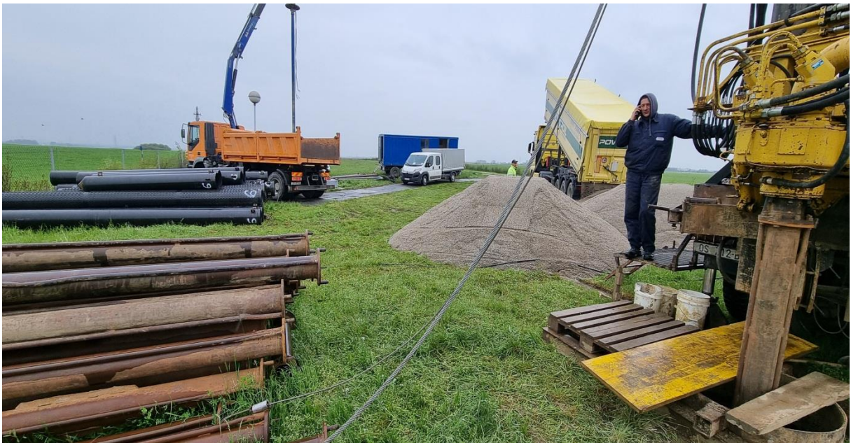
Slika 6: Bušenje zdenca Z-14 reverznom metodom
