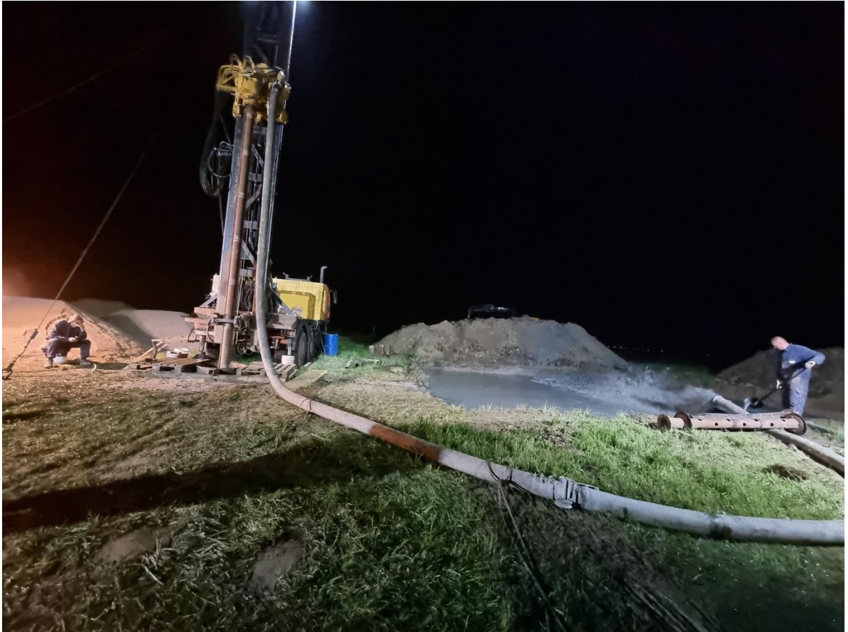
Slika 14: Voda na izlazu iz blende prije osvajanja 2
