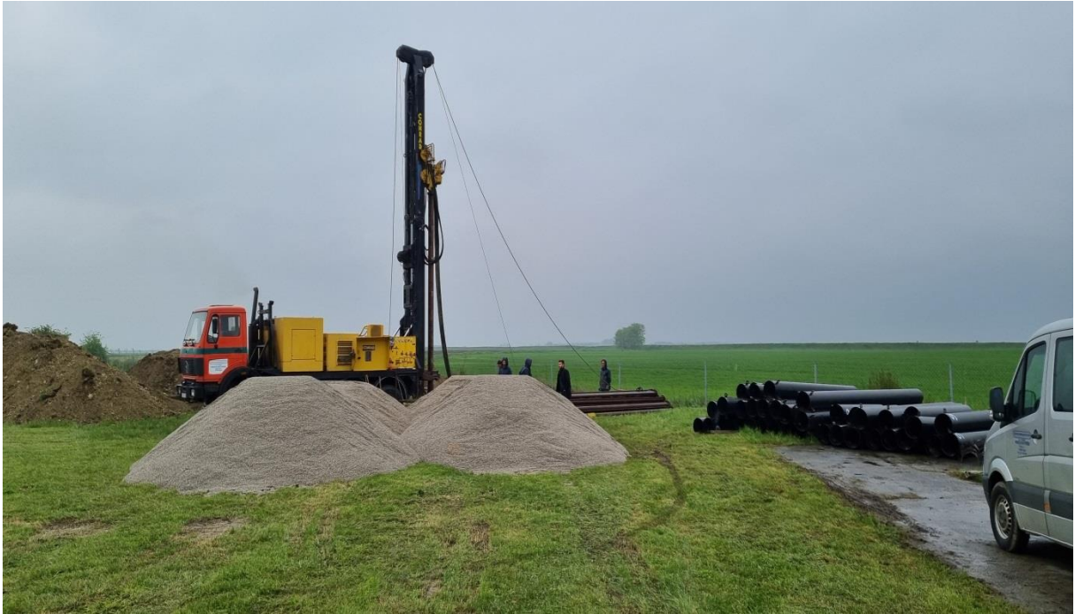
Slika 5: Reverzna hidraulična samohodna bušača garnitura CONRAD-COMAX 800 MK2 (Vodovod Osijek, 2020)
