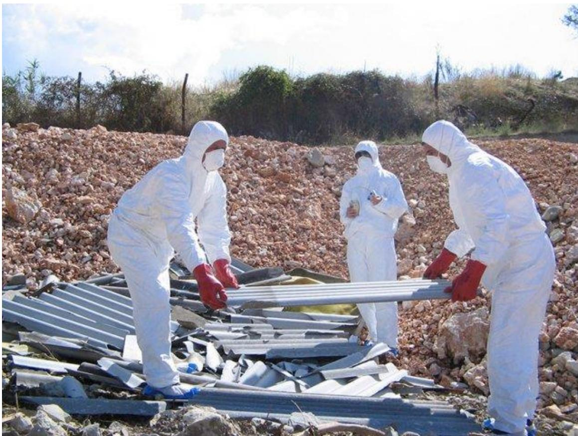
**Slika 2-5.** Rukovanje azbestom na adekvatan način (Cian d.o.o., 2020)
