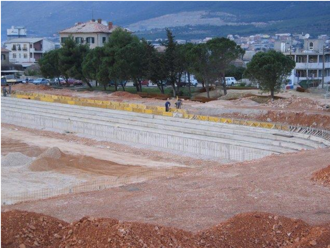
Slika 2-6. Pripremljene plohe za odlaganje azbesta na odlagalištu (Cian d.o.o., 2020)
