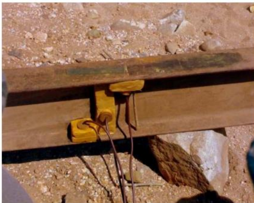
Slika 3-4. Primjena plastičnog eksploziva za rezanje metala (Bohanek i sur., 2013)
