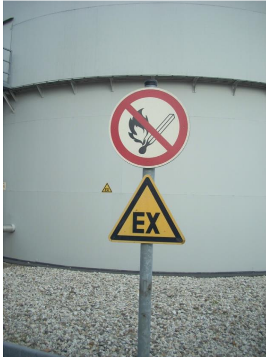
Slika 3-7. Znak upozorenja od požara i eksplozije (EPA 2011).
