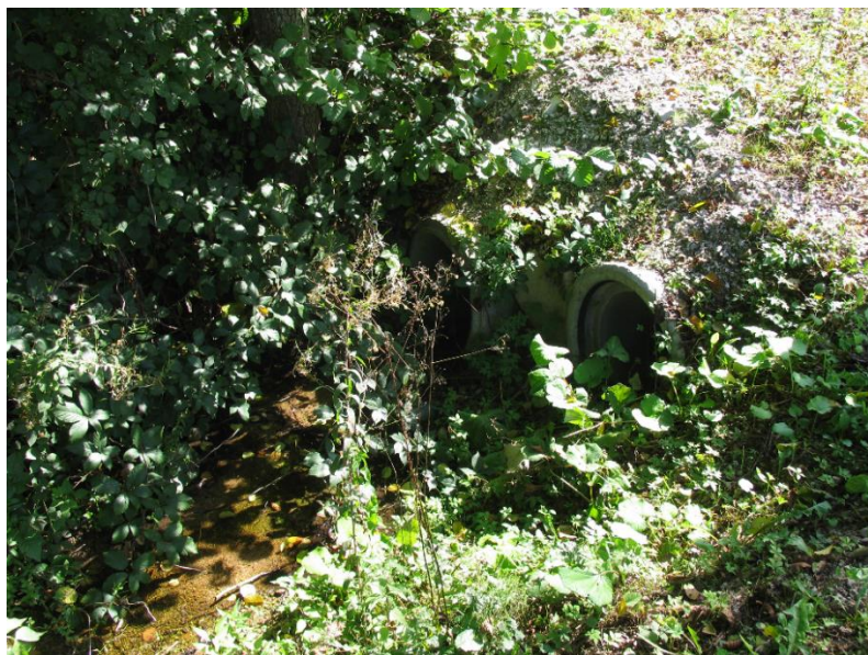
Slika 5-1 Uzvodna pregrada na Stiski uz ogradu izvorišta "Hrašće" (Nakić et al., 2008)
