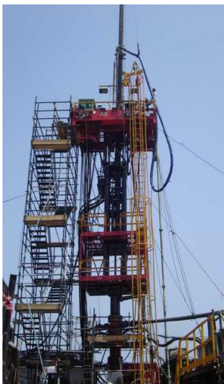
Slika 4-3. Prikaz hidrauličkog remontnog postrojenja tijekom bušenja s proizvodne platforme u odobalju (Huesecken, 2009)
