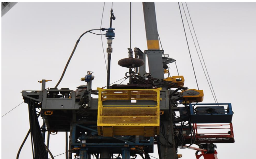
Slika 3-15. Prikaz isplačne glave i stojke na hidrauličkom remontnom postrojenju (Skinner, 2019)
