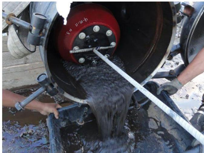
**Slika 3-2.** Nečistoće skupljene protiskivanjem čistača cjevovoda (<https://www.piping-world.com/>, 2019)
