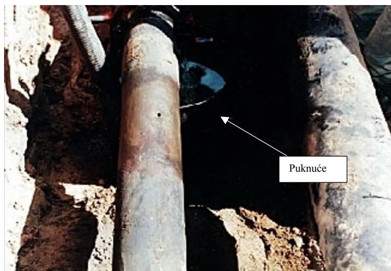
Slika 3-6. Puknuće cjevovoda zbog korozije (<https://www.ogj.com/home/>, 2000)
