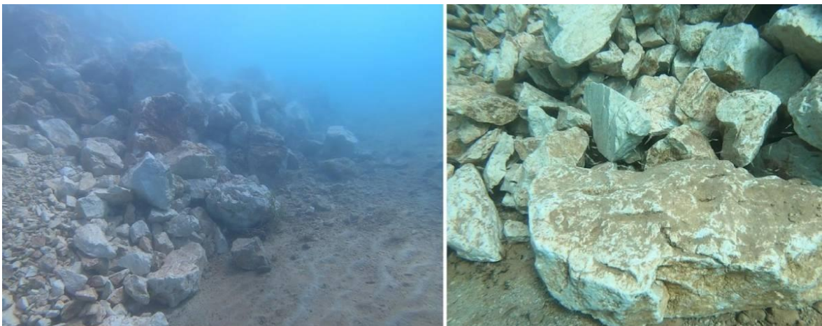
Slika 4-3. Podmorje prekriveno nedopuštenim nasipavanjem antropogenim materijalom (Jarić Dauenhauer, 2021).
