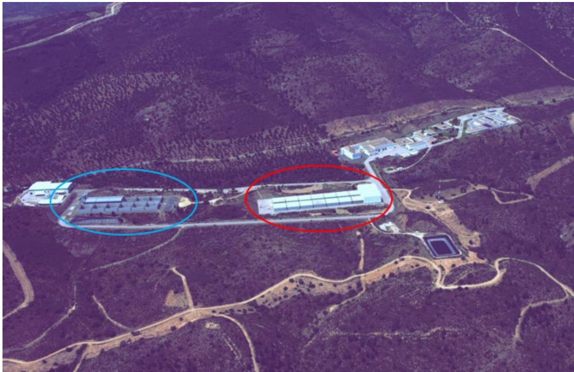
Slika 2.4. 28 betonskih kaseti. Sjeverni plato (crveno zaokruženo) sa 16 kaseti i Južni plato (plavo zaokruženo) sa 14 kaseti (TECNATOM, Nuclear sector).
