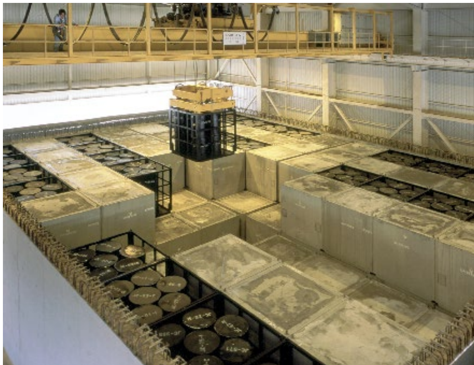
Slika 2.5. Punjenje betonske kasete s kockama (Enresa, El Cabril Disaposal Facility)
