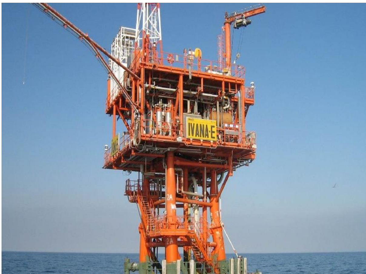
Slika 3-5. Platforma Ivana E (Fotodokumentacija INAgip)
