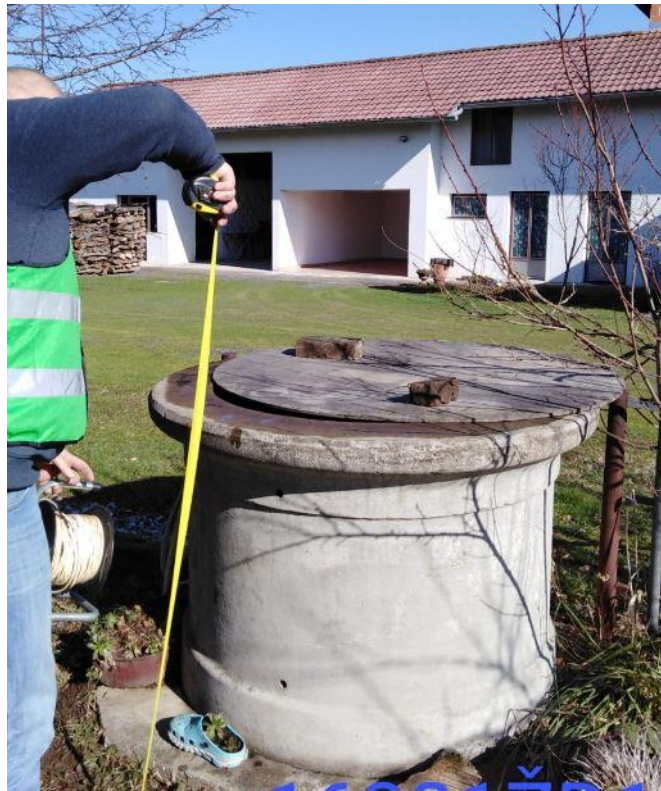
Slika 2-5. Mjerenje visine zdenca na terenu pomoću metra za mjerenje
