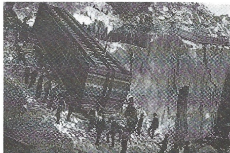
Slika 8 - Spuštanje zaštićenog velikog tereta po kliznoj svodnici
