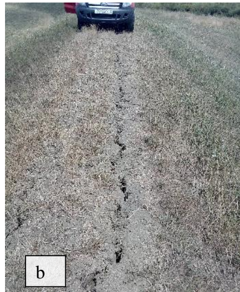
Slika 6.8 Jače sezonske pukotine na nasipu: (a) lokalno; (b) duž krune nasipa
