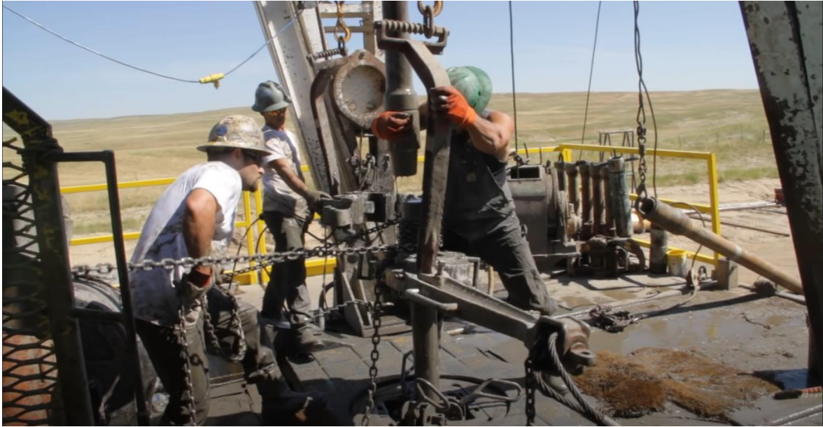
Slika 3-3. Dodavanje nove bušaće šipke upravo podignute iz mišje rupe na uklinjeni niz bušaćih alatki te njezino navrtanje pomoću lanaca i para ručnih kliješta (CalculatedRiskFilms, 2014)
