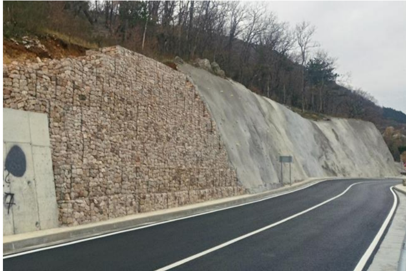
Slika 5-1. Gabionski zid uz prometnicu (Geotech, 2011)
