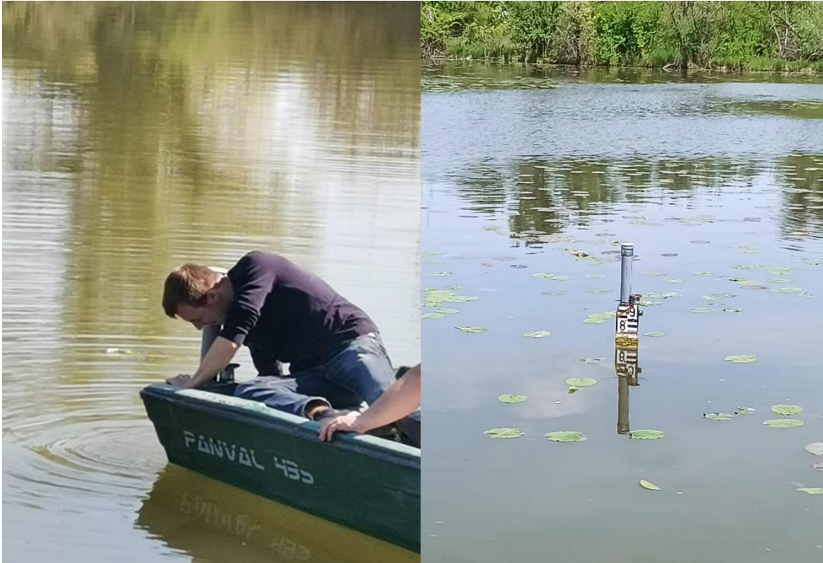
Slika 3.5 Učvršćivanje cijevi za vodokaznu letvu u Velikom jezeru. X=5070381,70 ; Y=463169,77
