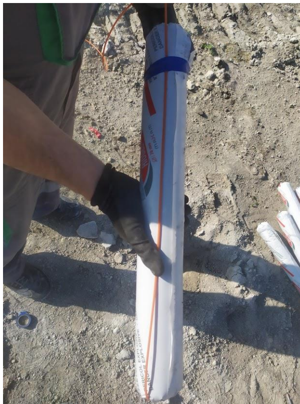
Slika 6-2 Spajanje patrone i nееlektričnog detonatora
