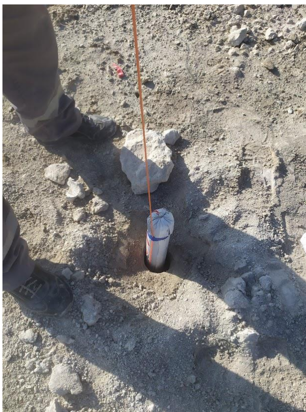
Slika 6-3 Postavljanje patrone u bušotinu
