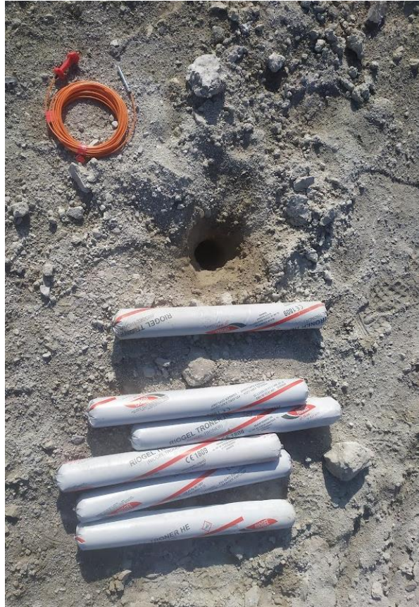
Slika 6-1 Neelektrični detonator i patrone za pojedinu bušotinu
