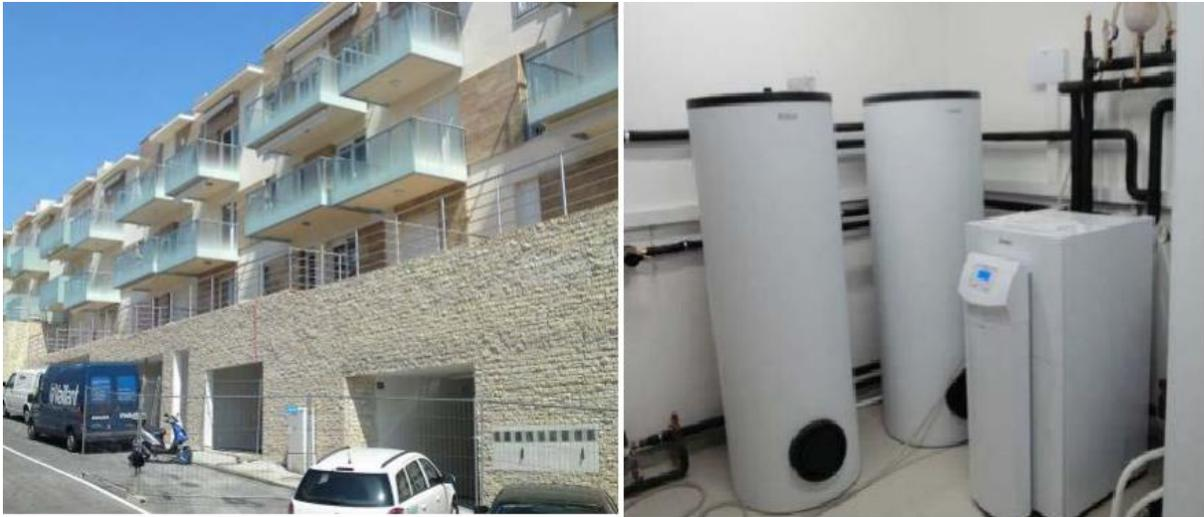
**Slika 3-8.** Sustav dizalice topline ugrađen u stambenu zgradu u Splitu (Seadrion Project, 2018a).
