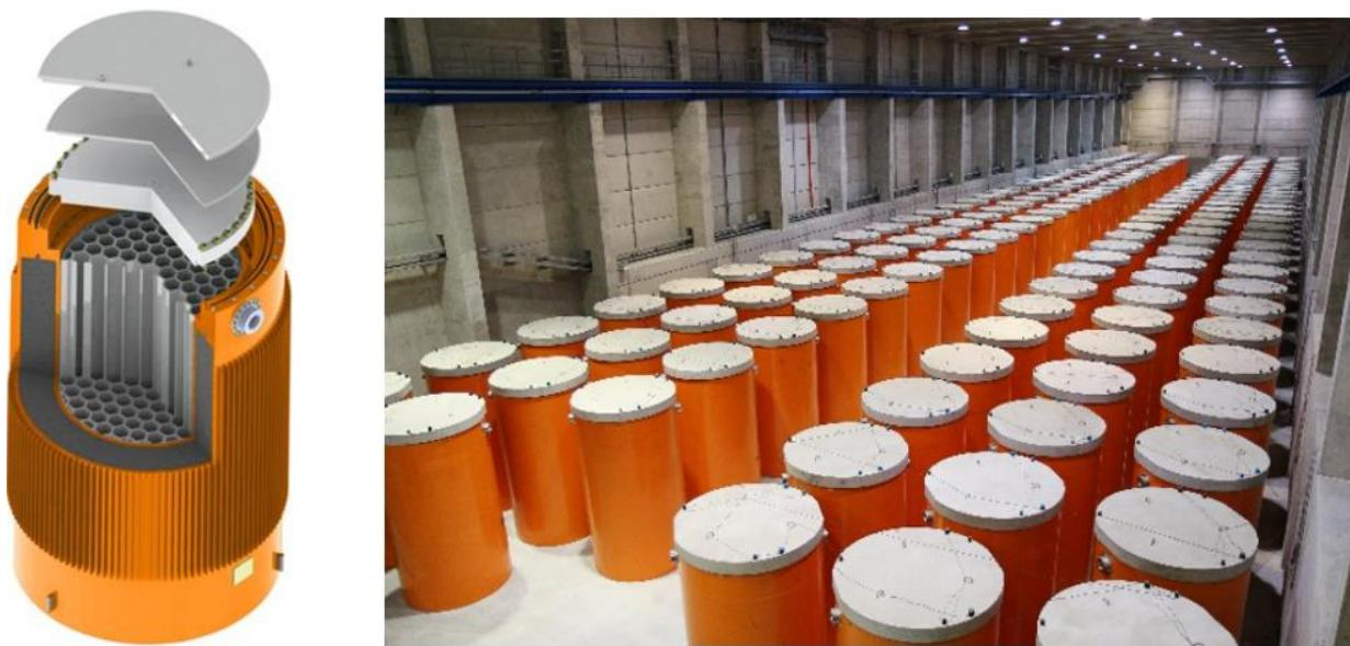
**Slika 2-3.** Dvonomjenski spremnik CONSTOR (lijevo) i suho skladište RAO-a (desno) (<https://www.gns.de>, 2022)
