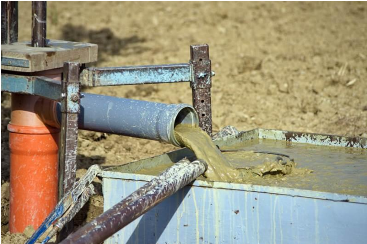
Slika 4-6. Bentonitna isplaka ( https://www.trenchlesspedia.com )
