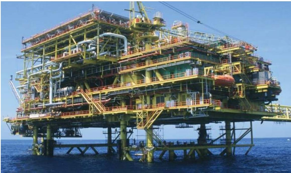
**Slika 4-1.** Separex membransko postrojenje instalirano na odobalnoj platformi (Honeywell UOP, 2011a)
