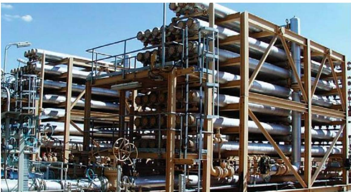
**Slika 4-2.** Separex membransko postrojenje instalirano u Egiptu (Honeywell UOP, 2011b)
