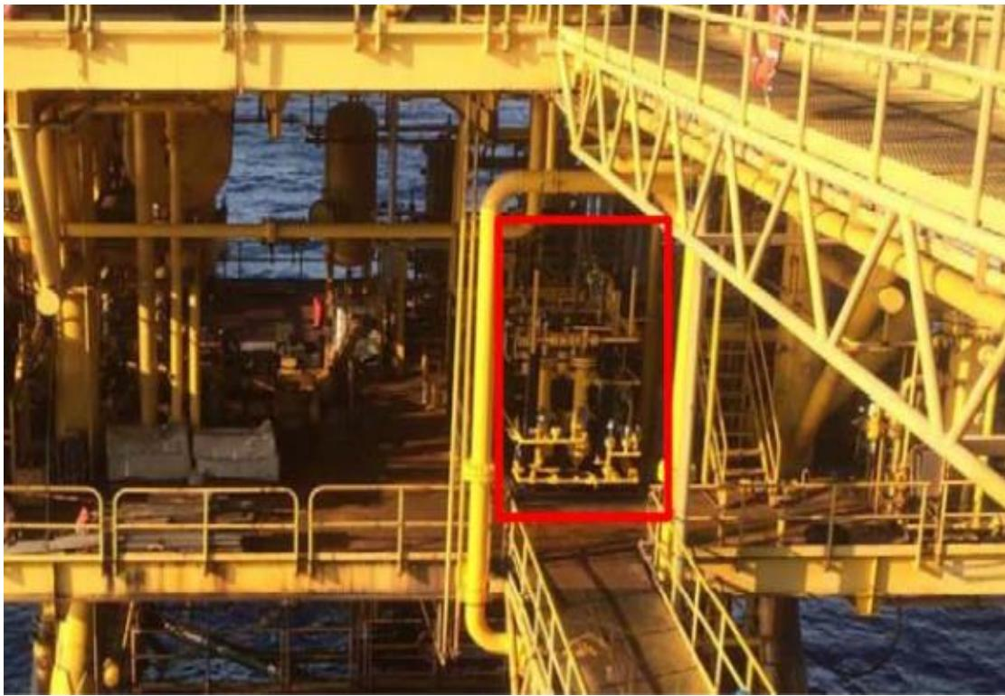
Slika 5-6. Sustav PEEK membrana za kondicioniranje plina kao goriva (Dengel et al., 2019)
