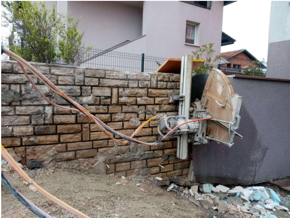
Slika 5-2. Dijamantno rezanje betonske ograde (Cro-rez, n.d.)
