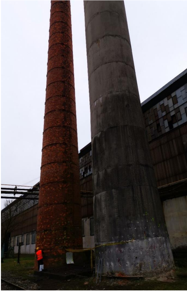
Slika 2-2. Betonski dimnjak tanke stijenke srušen eksplozivnim nabojem (Vukšić i Kosović, 2022)
