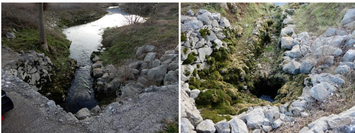
Slika 20. Točka opažanja hidrogeokemijskih parametara od prosinca 2014. godine do rujna 2020. godine, na izvoru Krenica kod Rastok polja – visoke vode (desno) i niske vode (lijevo).
