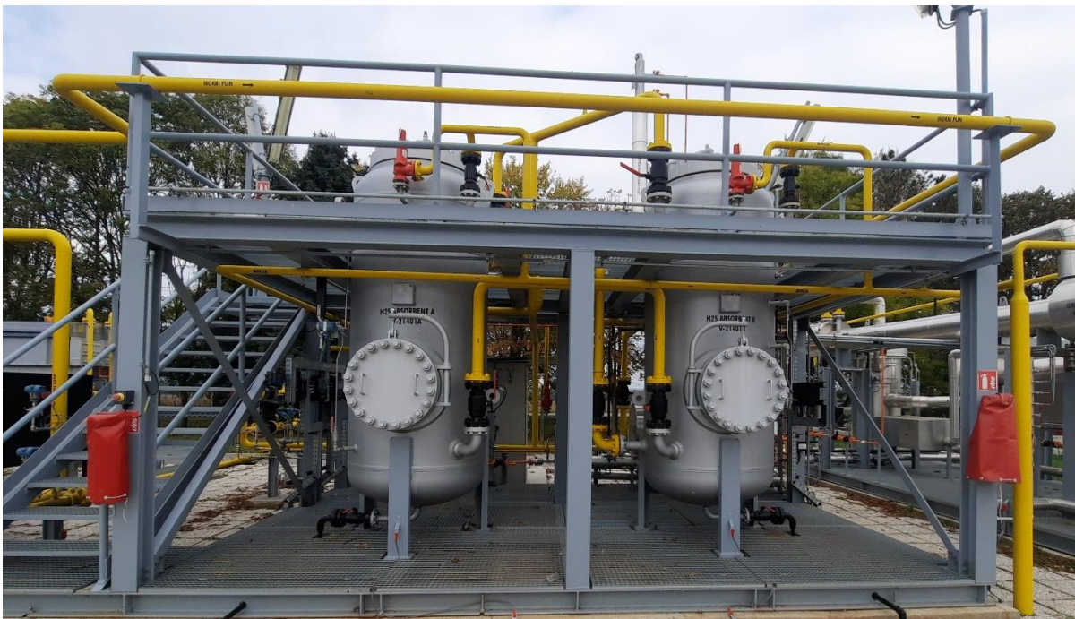
Slika 4-15. Jedinica za izdvajanje H_2S -a
