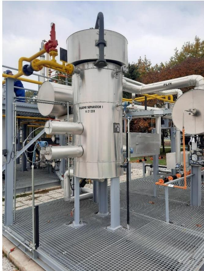
**Slika 4-9.** Nisko temperaturni separator I
