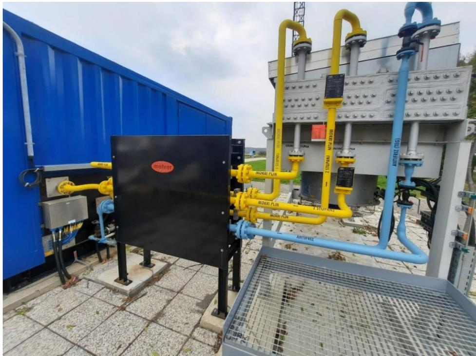
**Slika 4-4.** Spojevi vodova pojedinih stupnjeva komprimiranja kompresora i hladnjaka
