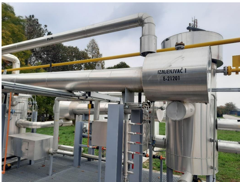
Slika 4-8. Izmjenjivač topline plin/plin
