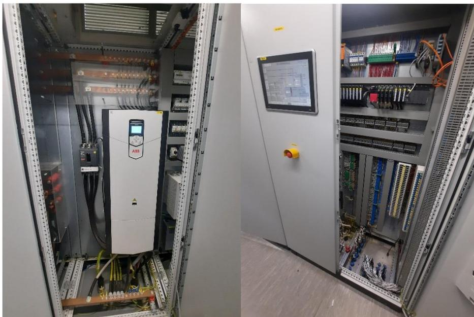
**Slika 4-5.** Frekvencijski pretvarač (lijevo); Sklop automatizacije i upravljanja postrojenjem (desno)
