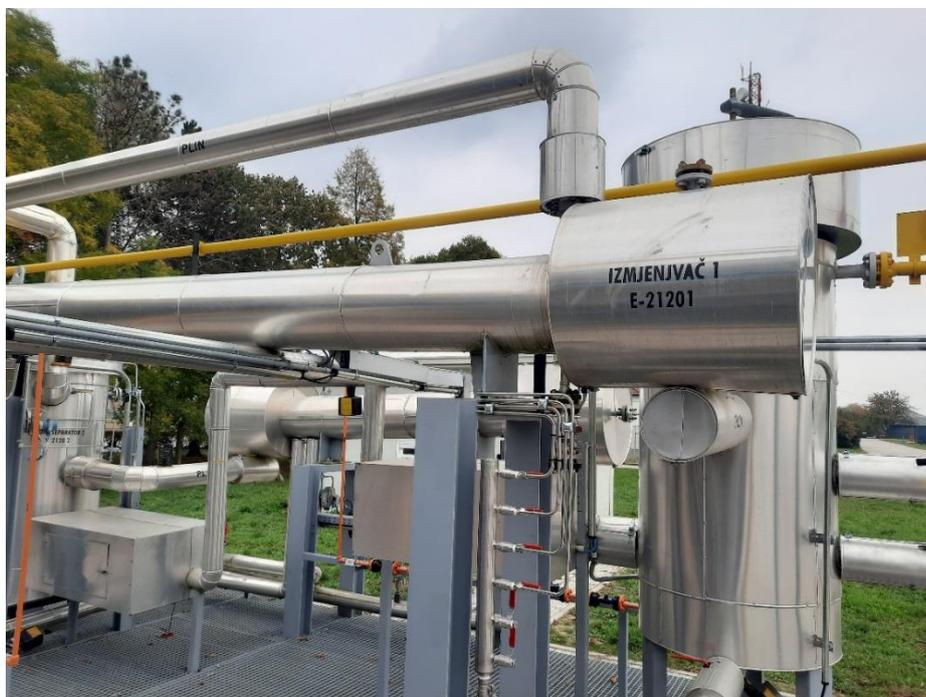
**Slika 4-8.** Izmjenjivač topline plin/plin
