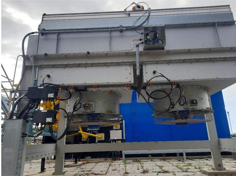
**Slika 4-3.** Zračni hladnjak kompresora
