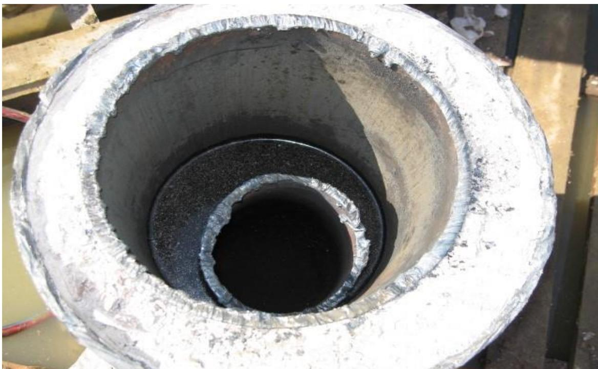
**Slika 4-1.** Prikaz ugrađenih i cementiranih nizova zaštitnih cijevi – 339,7 mm – 244,5 mm – 139,7 mm (CROSCO d.d., 2008)
