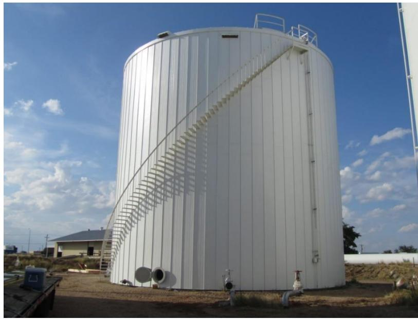
**Slika 7-1.** Prikaz uobičajnog spremnika za skladištenje biodizela (RIDGLOK, 2018)
