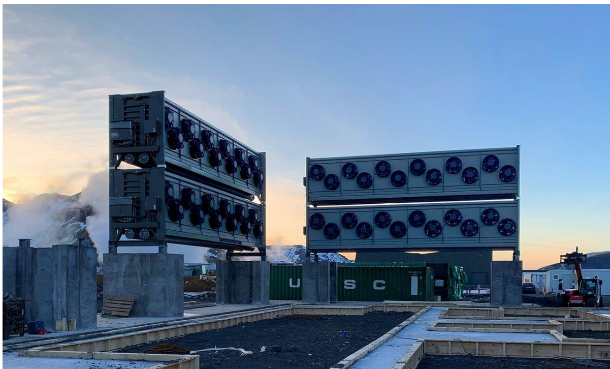
Slika 6-1. Jedinica za hvatanje ugljikovog dioksida na postrojenju Orca (Climeworks, n.d.)
