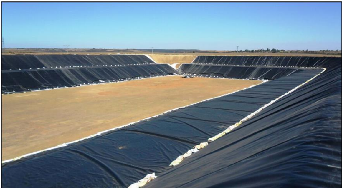
Slika 3-6. Postavljanje geomembrane na uređeno odlagalište komunalnog otpada (ATARFIL, 2022)
