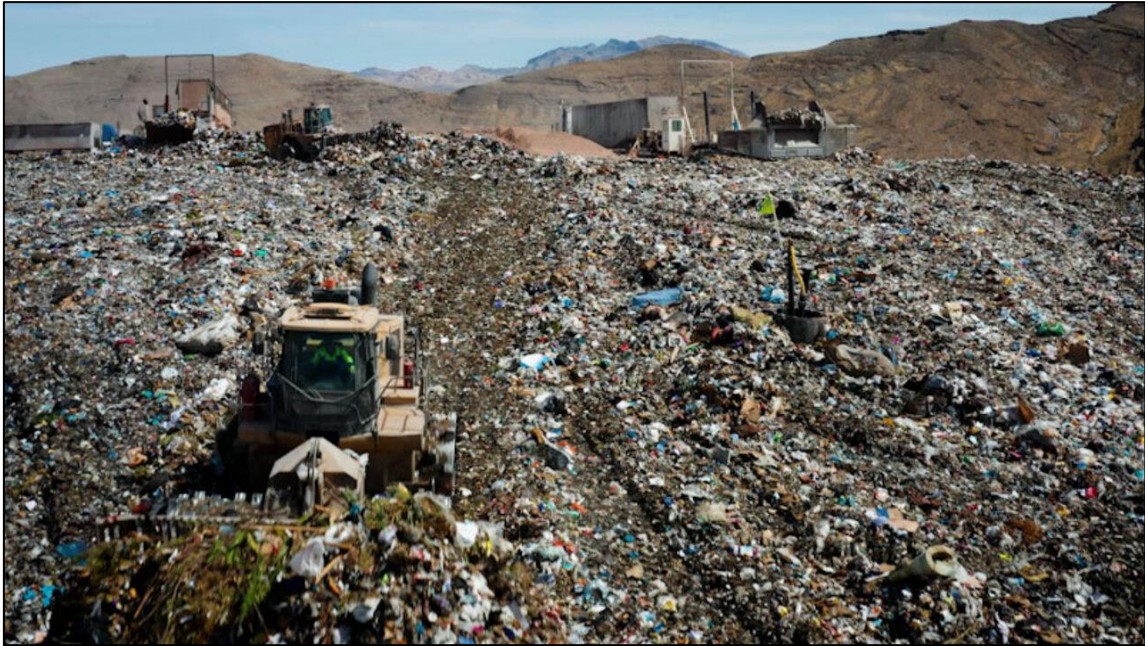
Slika 3-13. Odlagalište komunalnog otpada Apex Regional Landfill u Las Vegasu (DCMP, 2021)
