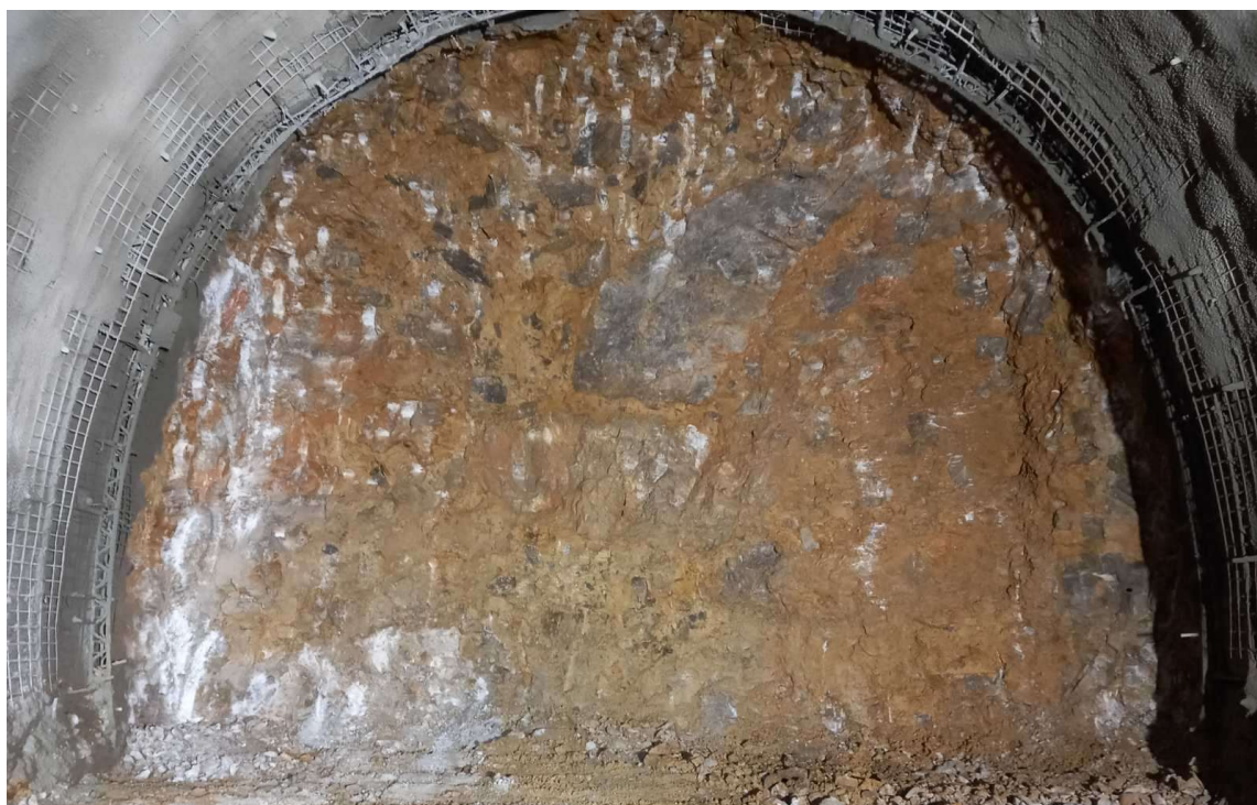
Slika 7-34. Iskop u vapnencu donje krede V. kategorije stijenske mase na stacionaži 35+132,00
