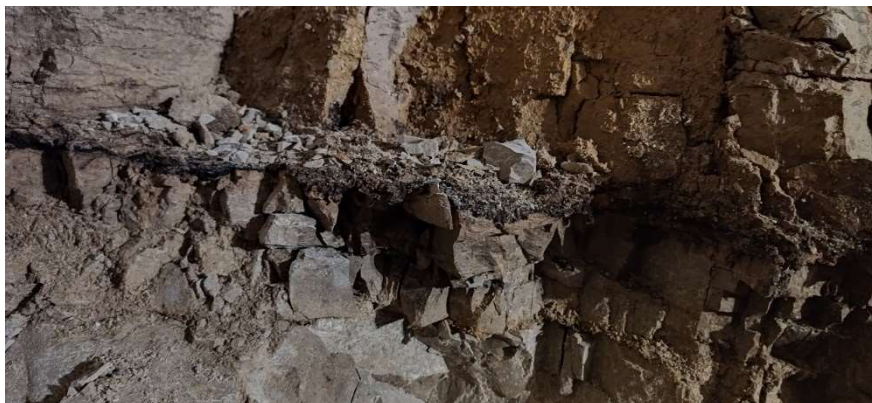
Slika 7-4. Bitumenizirana ispuna debljine veće od 5 mm po plohama slojevitosti 330/10 na stacionaži 30+612,00
