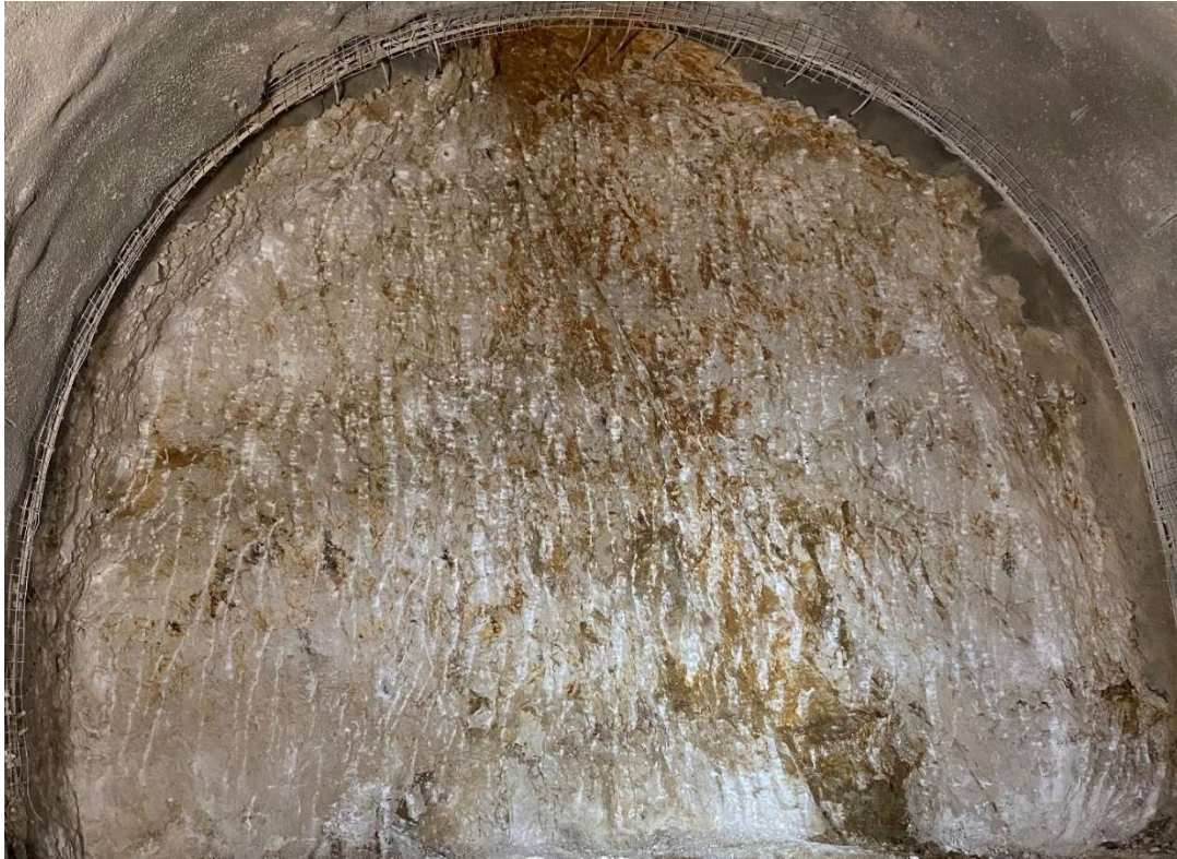
Slika 7-18. Iskop u rudistnom vapnencu gornje krede III. kategorije stijenske mase na stacionaži 31+094,00
