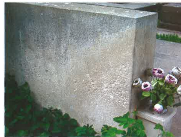
Sl. 5. Groblje u Pučišćima. Stražnja strana nadgrobne ploče djelomično je oštećena zbog nedovoljnog ispiranja kišom (2004.g.)
