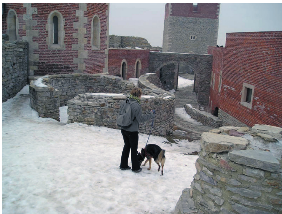
Slika 8. Oštećenja na dijelovima zidina Medvedgrada
