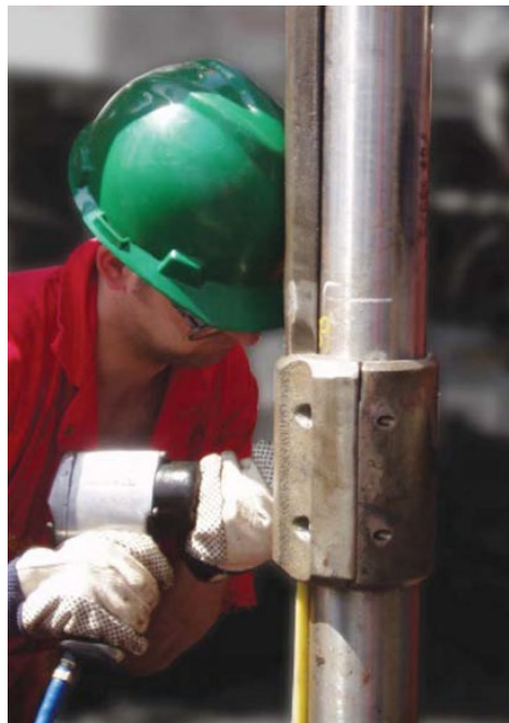
Slika 2-40. Ugradnja zaštitne ploče kontrolnog voda (Bellarby, 2009)
