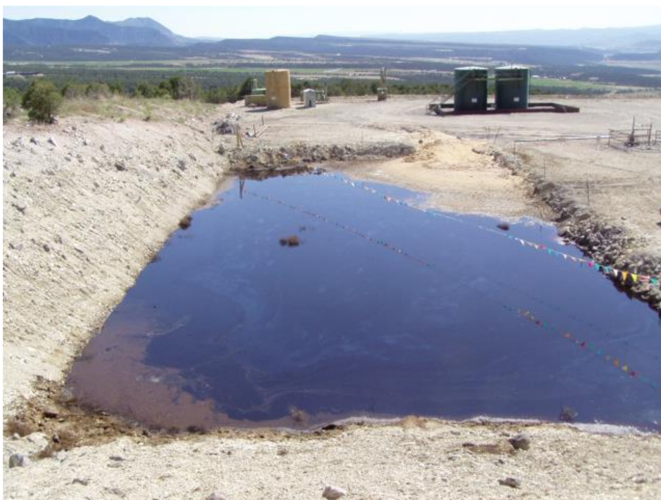
Slika 3-5. Pomoćna otpadna jama uz završenu bušotinu (Ramirez, 2009)
