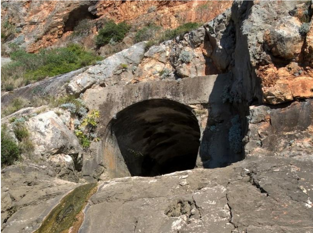
Slika 2-3. Izlaz na južnom djelu odteretnog tunela
