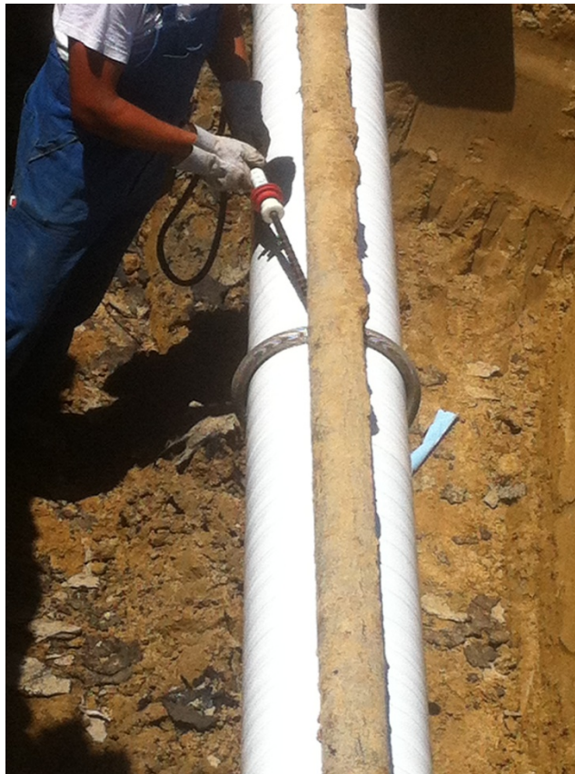
Slika 8-2. Ispitivanje propuštanja izolacije nakon namatanja nove izolacije
