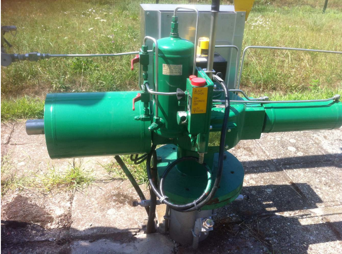
Slika 5-2. Nadzemni dio blokadnog uređaja s jedinicom za ručno pokretanje
