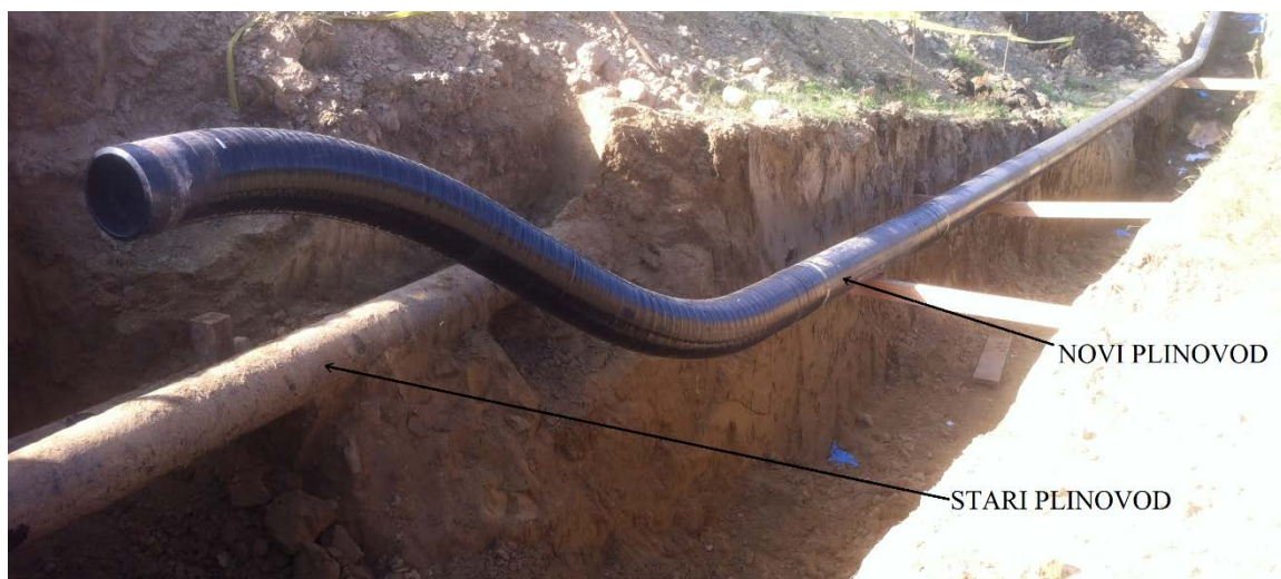
Slika 8-5. Stari i novi plinovod u mjestu Vagovina
