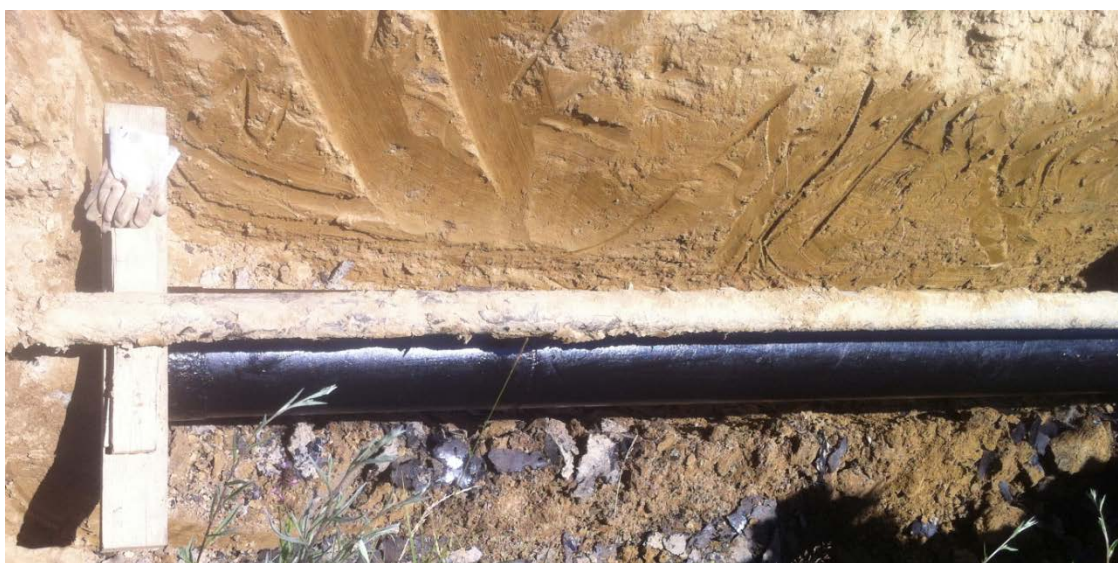
Slika 8-1. Plinovod nakon nanošenja temeljnog premaza
